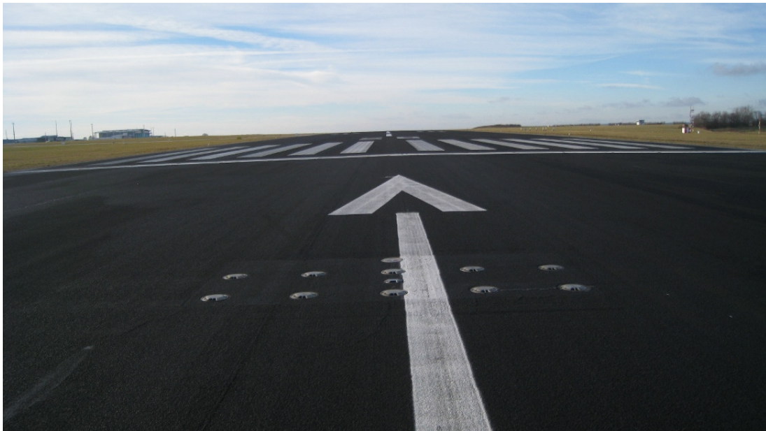
Bild 1: Start- und Landebahn, Piste 28 des Flughafens Erfurt Weimar, Blick vom Startbahnkopf in Richtung Westen
