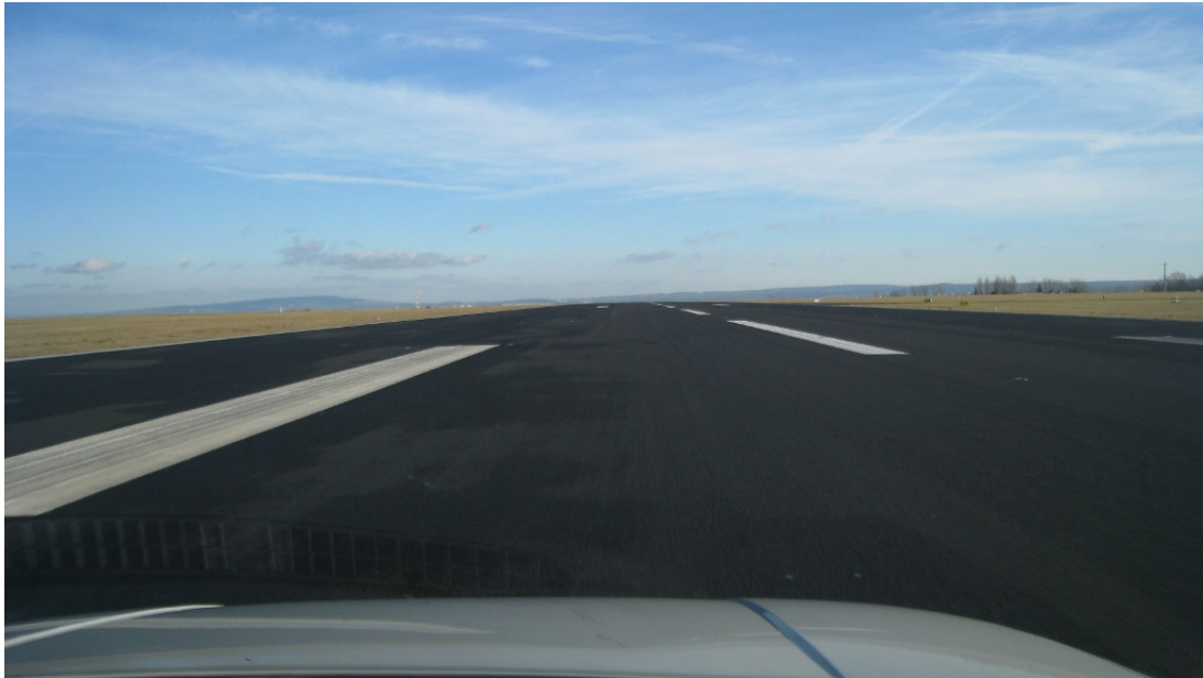
Bild 3: Mittelbereich der S/L-Bahn; auch nach abtrocknendem Regen sind keinerlei Rissbildungen erkennbar
