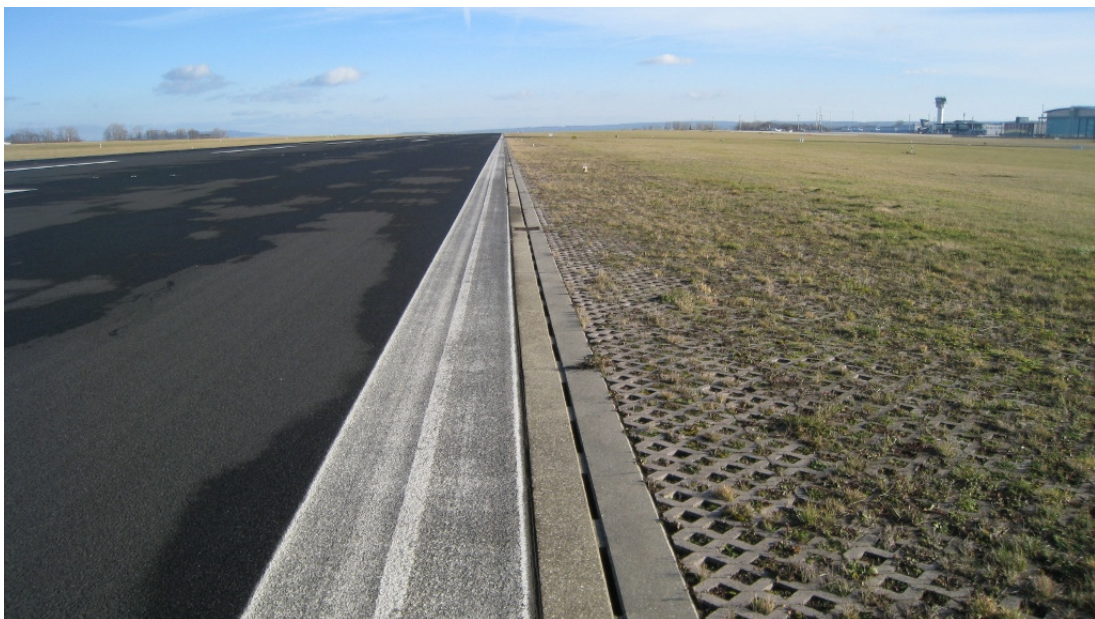
Bild 2: Randbereich und Schulter der Start und Landebahn – keine Risse, keine aufgehenden Fuge und Anschlüsse
