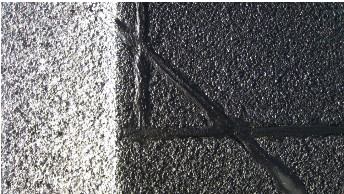
Bild 8: Detail einer vergossenen Induktionsschleife
