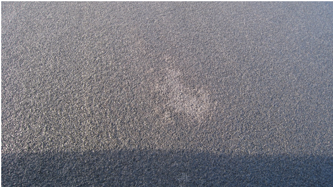
Bild 5: Gleichmäßige Struktur des Anti-Skid-Belages
