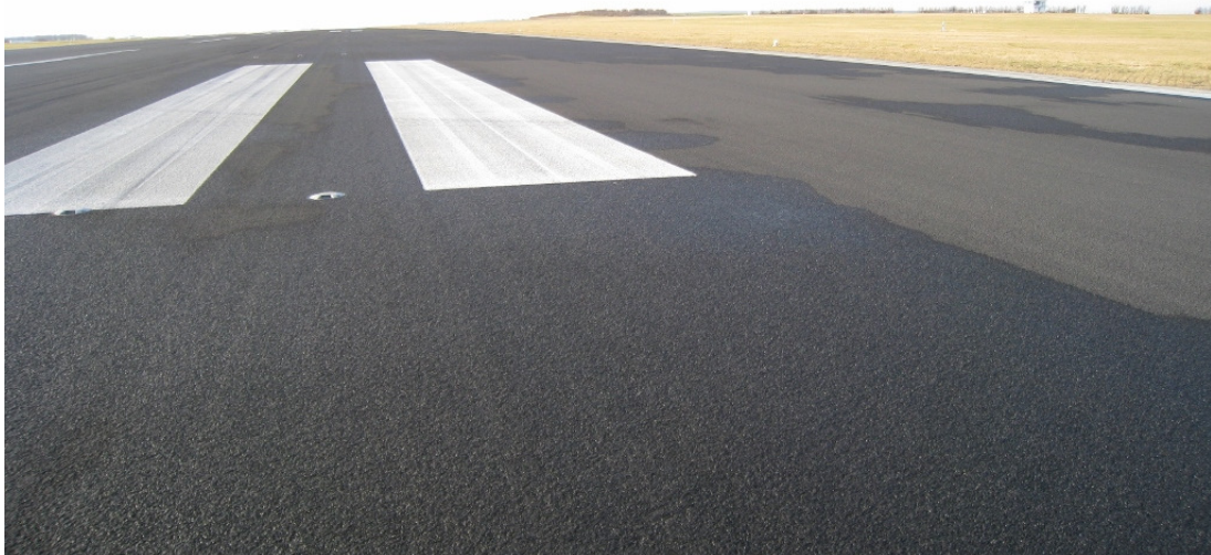
Bild 4: Blick zum westlichen Startbahnkopf der S/L-Bahn; in den Markierungen sind ebenfalls keinerlei Rissbildungen erkennbar
