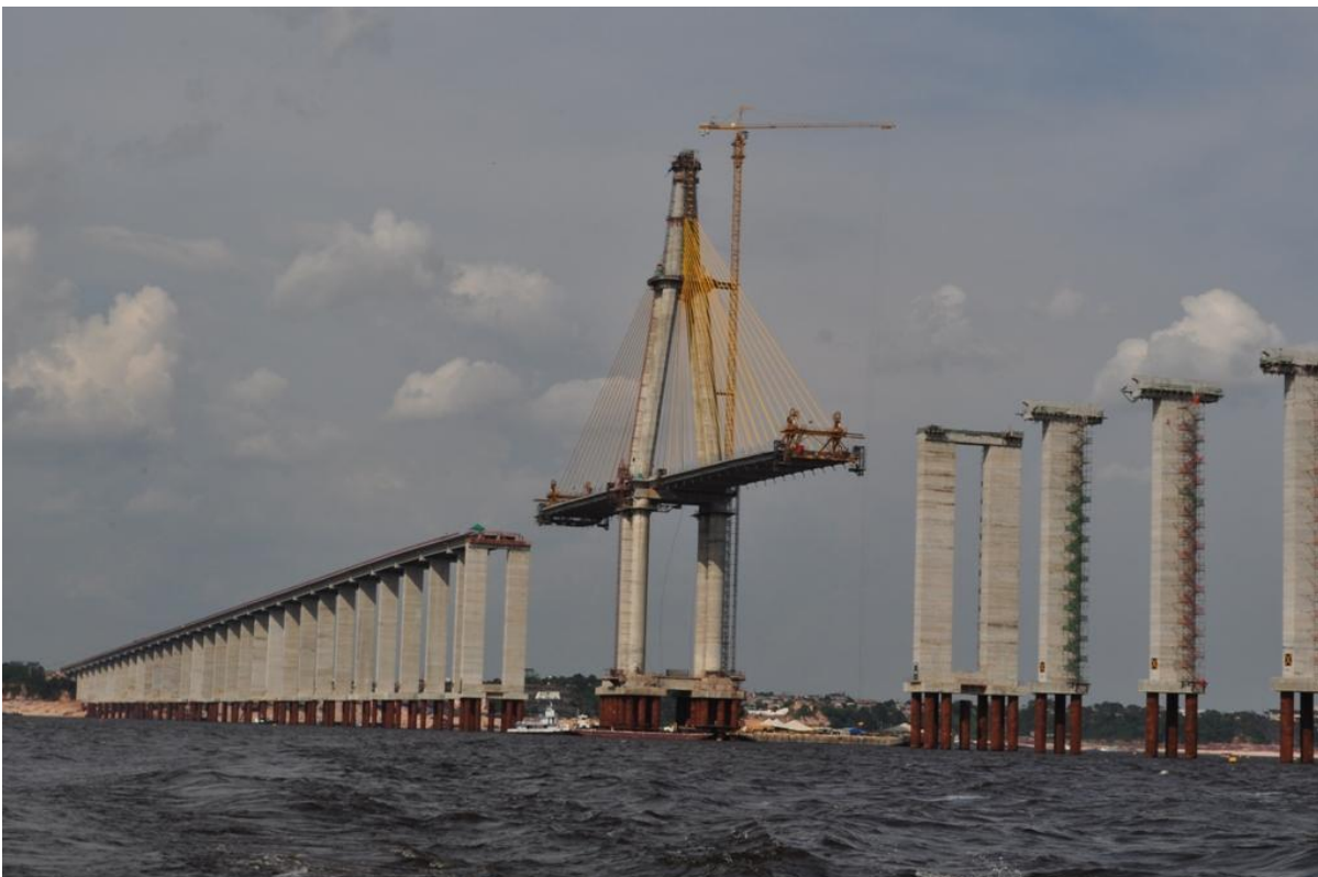
De Rio Negro brug in Brazilië is uitgerust met tuikabels en voorgespannen strengen van Bekaerts joint venture vestigingen.
