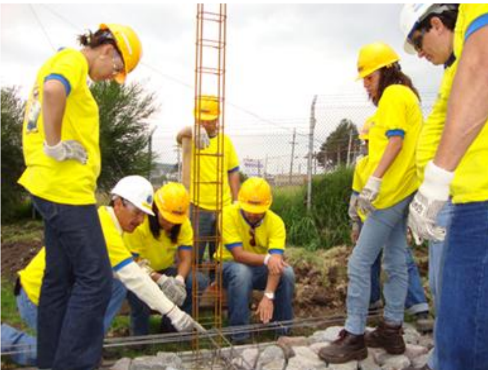
Onze vestiging in Ecuador publiceerde the 'Manual para la Construcción'. Tijdens workshops worden bouwvakkers opgeleid om aardbevingsbestendige huizen te bouwen voor gezinnen met een beperkt inkomen.
