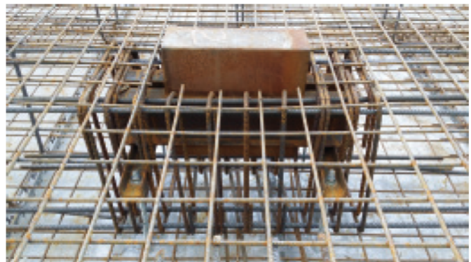
Bild 5. Detail: Ankerkästen in der Fundamentplatte
