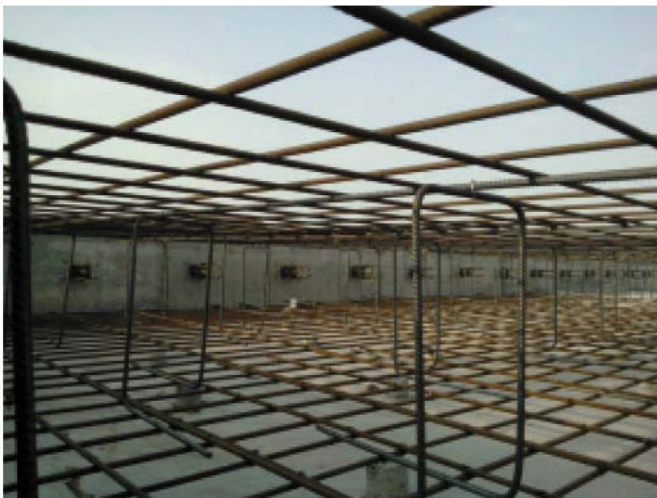
Bild 2. Entspannte Bewehrungsführung der Fundamentplatte
