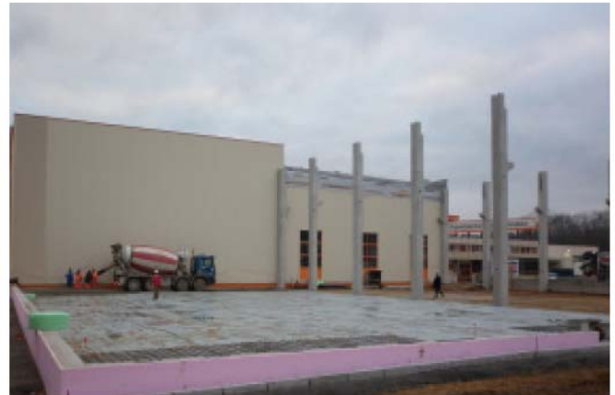
Bild 8. Einzige Betonstahlbewehrung unter den Aussteifungstürmen
