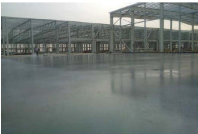
Bild 3. Fertige Oberfläche der Fundamentplatte eines Plattenfelds
