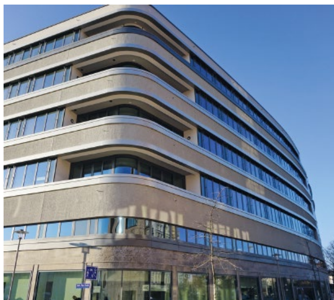
Bild 1 Schon lange keine Zukunftsmusik mehr – Stahlfaserbeton im Einsatz bei mehrgeschossigen Gebäuden No future dream anymore – steel fibre reinforced concrete for multi-storey buildings
