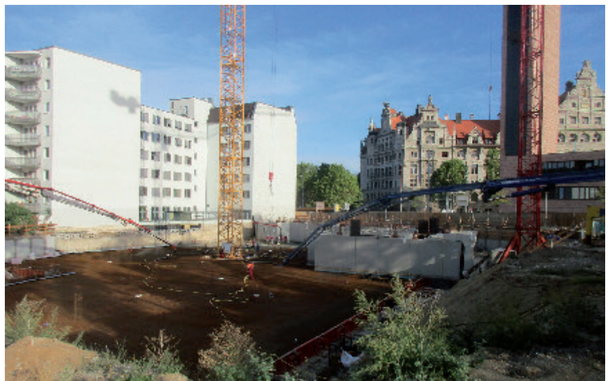
Die Tiefgarage wird mit Stahlfaserbeton ausgeführt.
