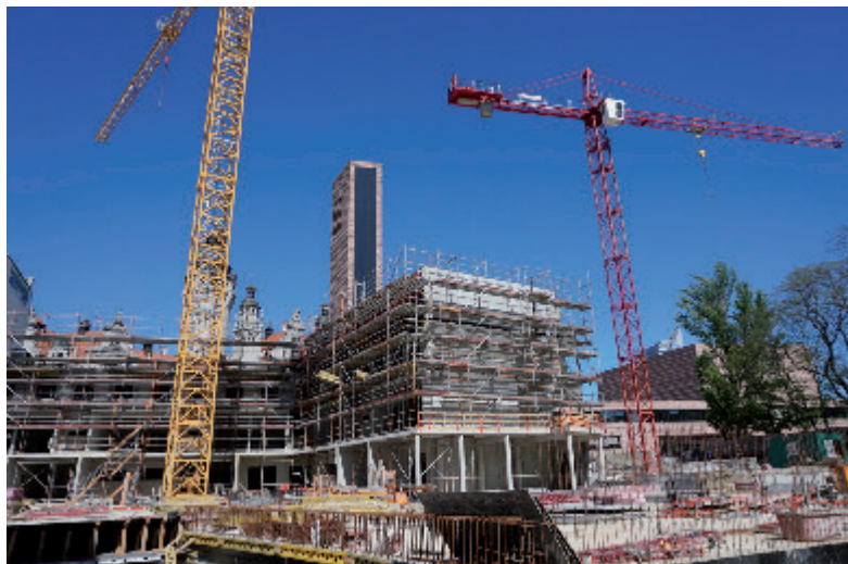
Der Einsatz von Stahlfaserbeton führte zu Material- und Zeiteinsparungen.
