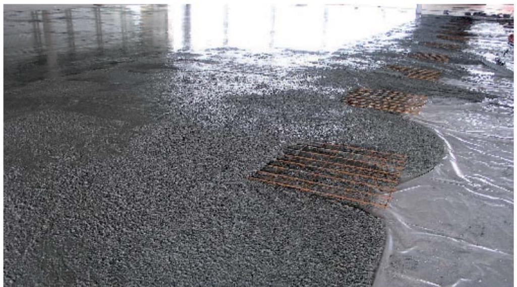
Mattenpatches können die Zulagebewehrung bei pfahlgestützten Bodenplatten bilden.
