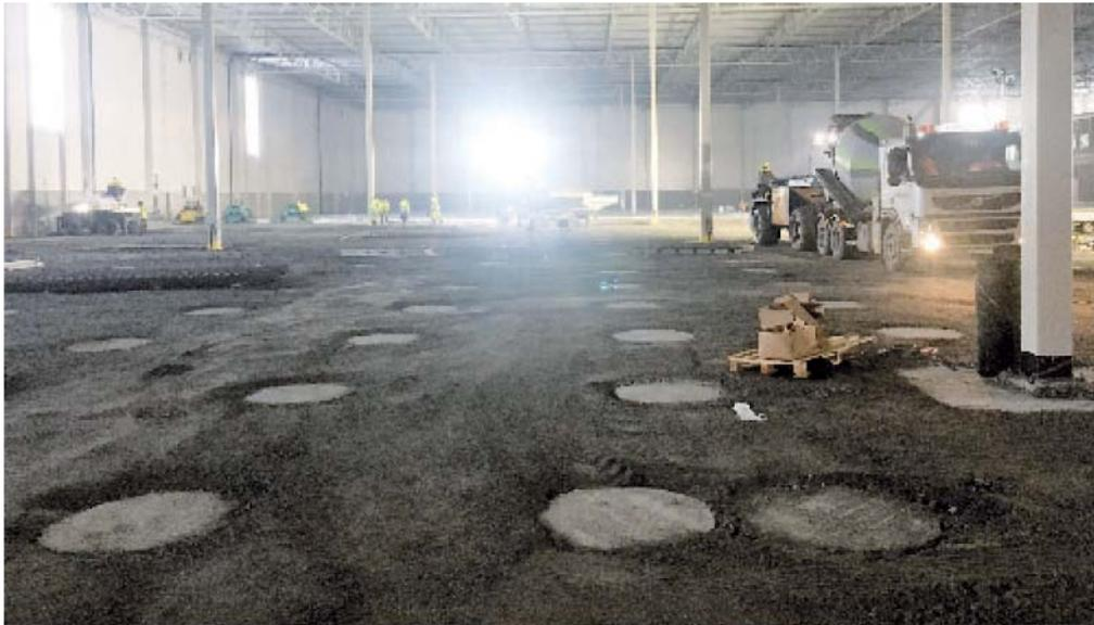
Mit LaserScreed und Betonmischer wird der Dramix-Stahlfaserbeton mit oberer vollflächigen Bewehrung eingebaut.
