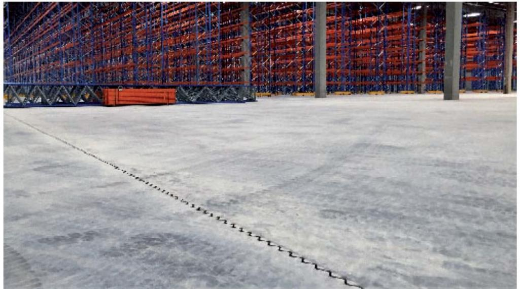
Dramix-Stahldrahtfasern bietet eine rein mit Stahlfaserbeton bewehrte Bodenplatte auf Pfählen.
