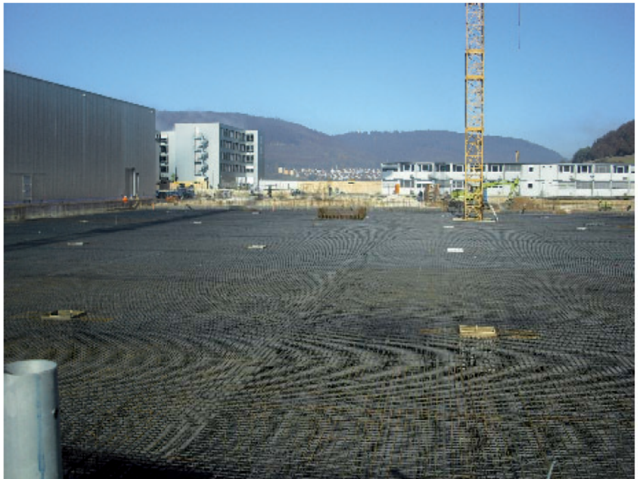
Industrieboden mit 220 Zentimeter Plattenstärke – Carl Zeiss Oberkochen.
