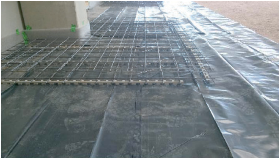
Unverzichtbare Details – Kerbrissbewehrung an einspringenden Ecken.
