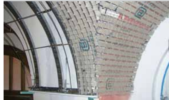
Bekaert Stucanet ® panelen zijn heel buigzaam, en kunnen gemakkelijk op metalen profielen worden aangebracht.
